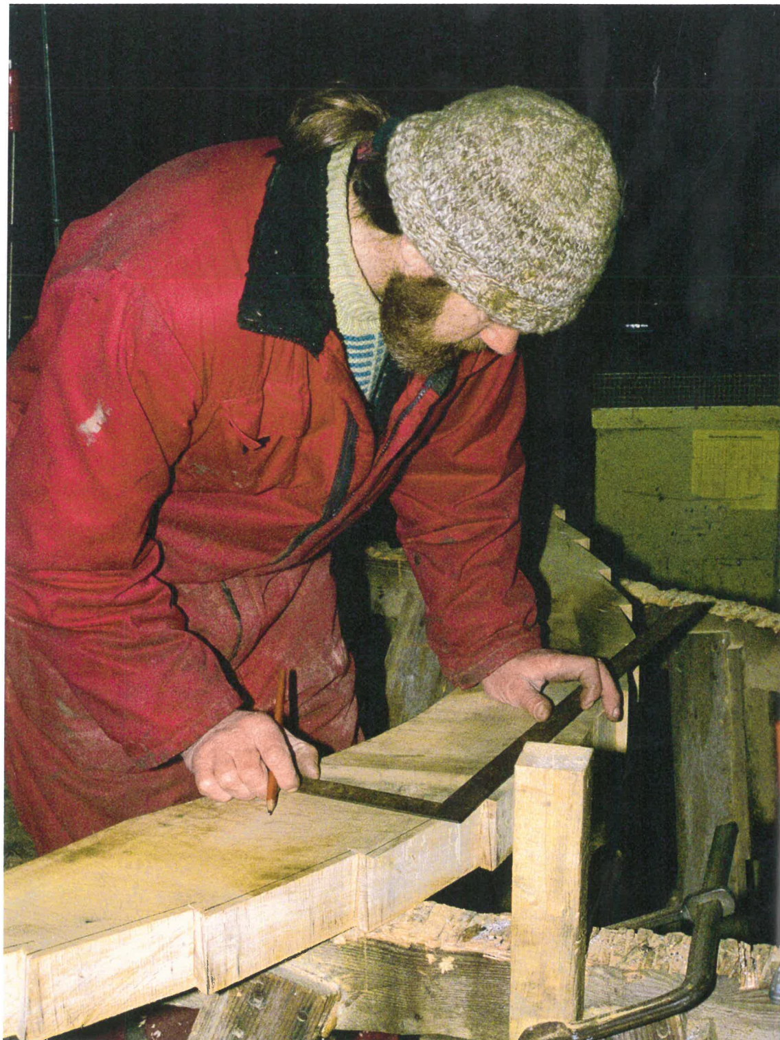
Smigen tegnes op og hugges til med skarøkse.
