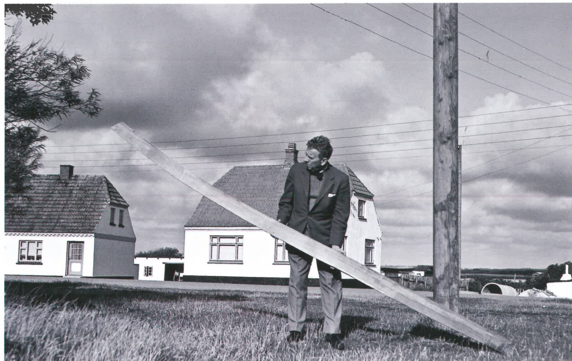
Ovenfor: En havbådebyggers udgangspunkt for sit specifikationsforløb. De første bords tilskæring er for klinkbådebyggeren det afgørende for, at bordet lægger sig ud efter hensigten, når det klemmes ned, og den rigtige bådform vokser ud af arbejdet. Olof Hasslöf fotograferet med mal til et bord fra bådebyggerlægten Bondes værksted. Stenbjerg Bådebyggeri 1965.
