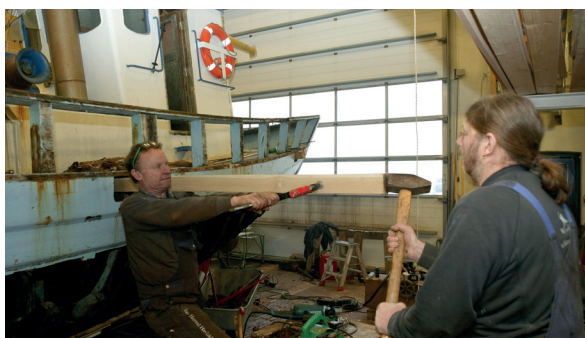
Peter slår en ny dæksbjælke ind under dækket på Hebron.
